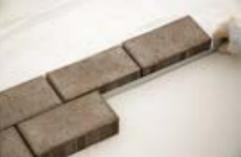
Для формирования ровного шва используется направляющий профиль. При наличии опыта допускается укладка тротуарного клинкера без профиля.
