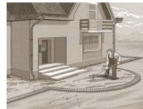
Подсыпка равномерно распределяется по поверхности несущего слоя и предварительно разравнивается с помощью подручного инструмента (например, граблей). Монтажный слой трамбуется (уплотняется) специальным электро- или бензоинструментом (виброплита).
