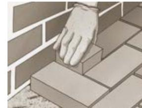
В местах примыкания мощения к границам площадки всегда остаются пустоты, меньше целого кирпича по размеру. Они заполняются доборными кирпичами, которые изготавливают при помощи отрезной пилы («болгарка») или циркулярная пила с диском для камня.
