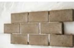
Обязательно качественное заполнение швов абсолютно сухим песком, либо послойное заполнение влажным песком с последующей проливкой за 2-3 раза. В процессе эксплуатации участка, в случае вымывания песка, производится просыпка швов.
