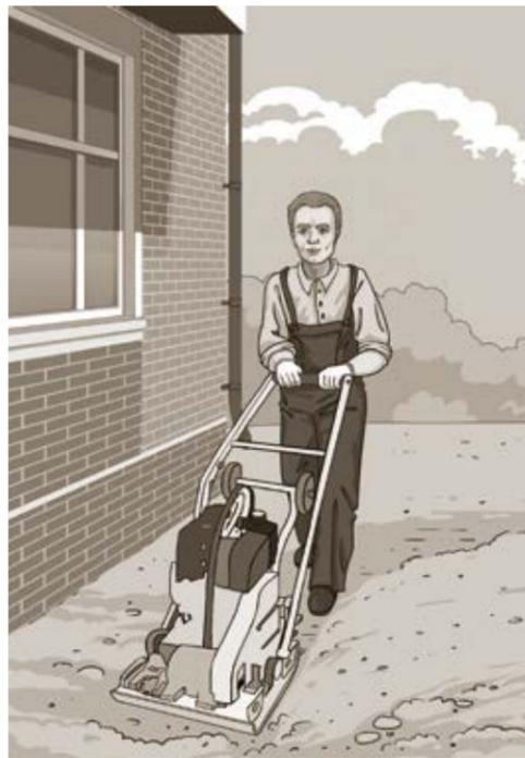
Качественное выполнение работ по подготовке основания на больших площадях может быть обеспечено при использовании автотракторной техники: бульдозер, грейдер, каток и пр. Участки площадью до 100-150 кв.м, а также участки сложной формы, удобнее подготавливать с помощью специального электро- и бензоинструмента (виброплита, виброрейка и пр.)
