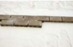
Швы заполняются сеянным песком, модуль крупности которого не должен превышать размеры шва.
