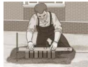
Бордюр формируется укладкой клинкера на ребро. Возможны и другие варианты: установка клинкерных кирпичей на тычок (вертикально) или использование специальных бордюрных камней.
