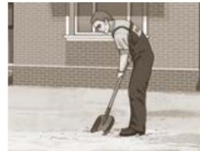
На уплотненный грунт отсыпается и разравнивается необходимое количество песка (ПГС, отсева).
