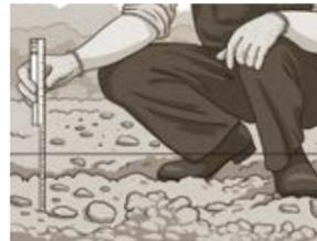
При подготовке несущего слоя осуществляется разметка участка. В ходе разметки участка определяются высоты, углы, направление уклона для дренажа. Для фиксации разметки натягиваются нити.
