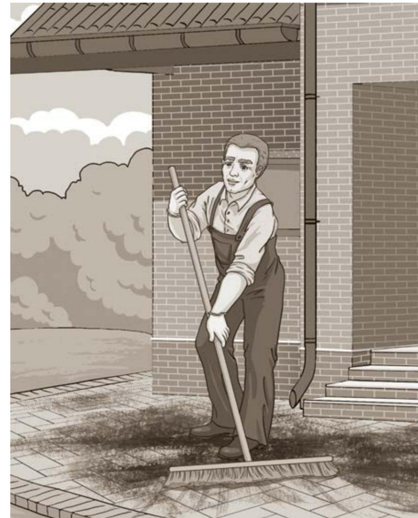
Швы финишно заполняются с помощью щетки. Для заполнения используют песок мелкой фракции (Mk<2,0). Проливка швов способствует уплотнению песчаного заполнителя. Для заполнения швов можно использовать цветные смеси. Уплотнение облицовочного слоя производится при помощи виброплиты (m < 100 кг) с защитной плитой из неопрена.
