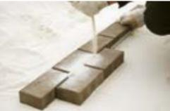
Заполнение швов производится в процессе укладки клинкера. Во избежание смещения кирпичей заполняются каждые 2 ряда.
