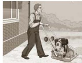
Основание обязательно утрамбовывается. Применять для уплотнения основания ручные трамбовки «бабы» не следует, поскольку с их помощью трудно обеспечить равномерность подготовки.
